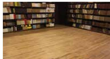
Estas dos antiguas salas poseen un piso entablonado de madera de pinotea flotante el cual estaba cubierto por un camino de alfombra, el que fue levantado para luego pulir ambas salas y de esta manera resaltar el entablonado existente.
